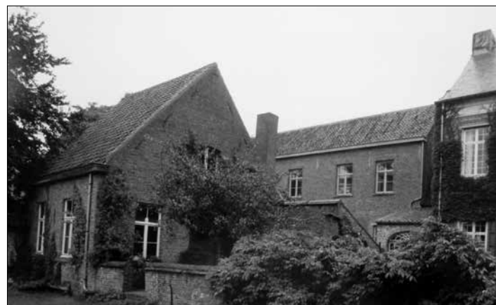
Zicht op de achterzijde en bijgebouw in 1993 (foto J. Winckelmans)
